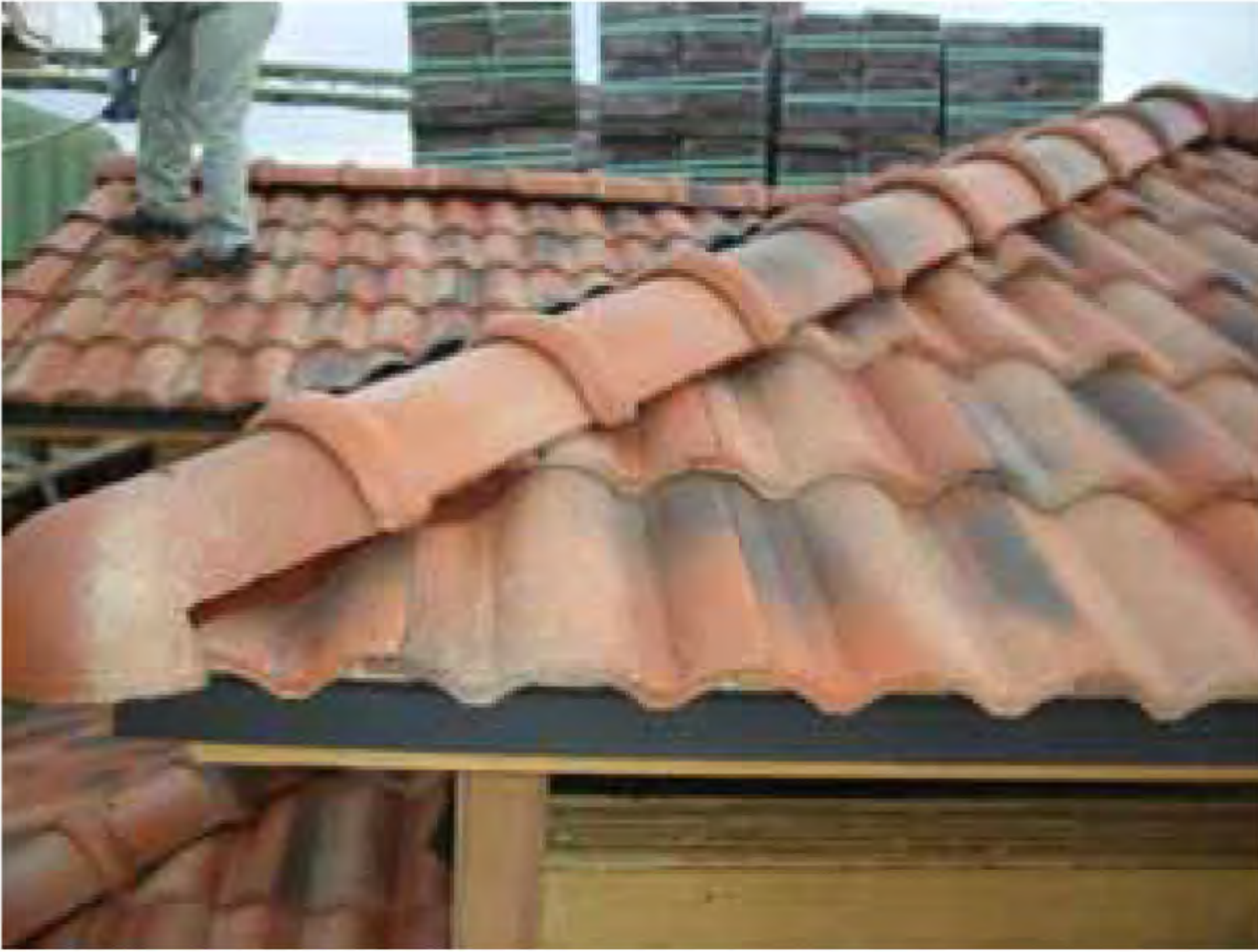
メタルロールの施工完成写真
