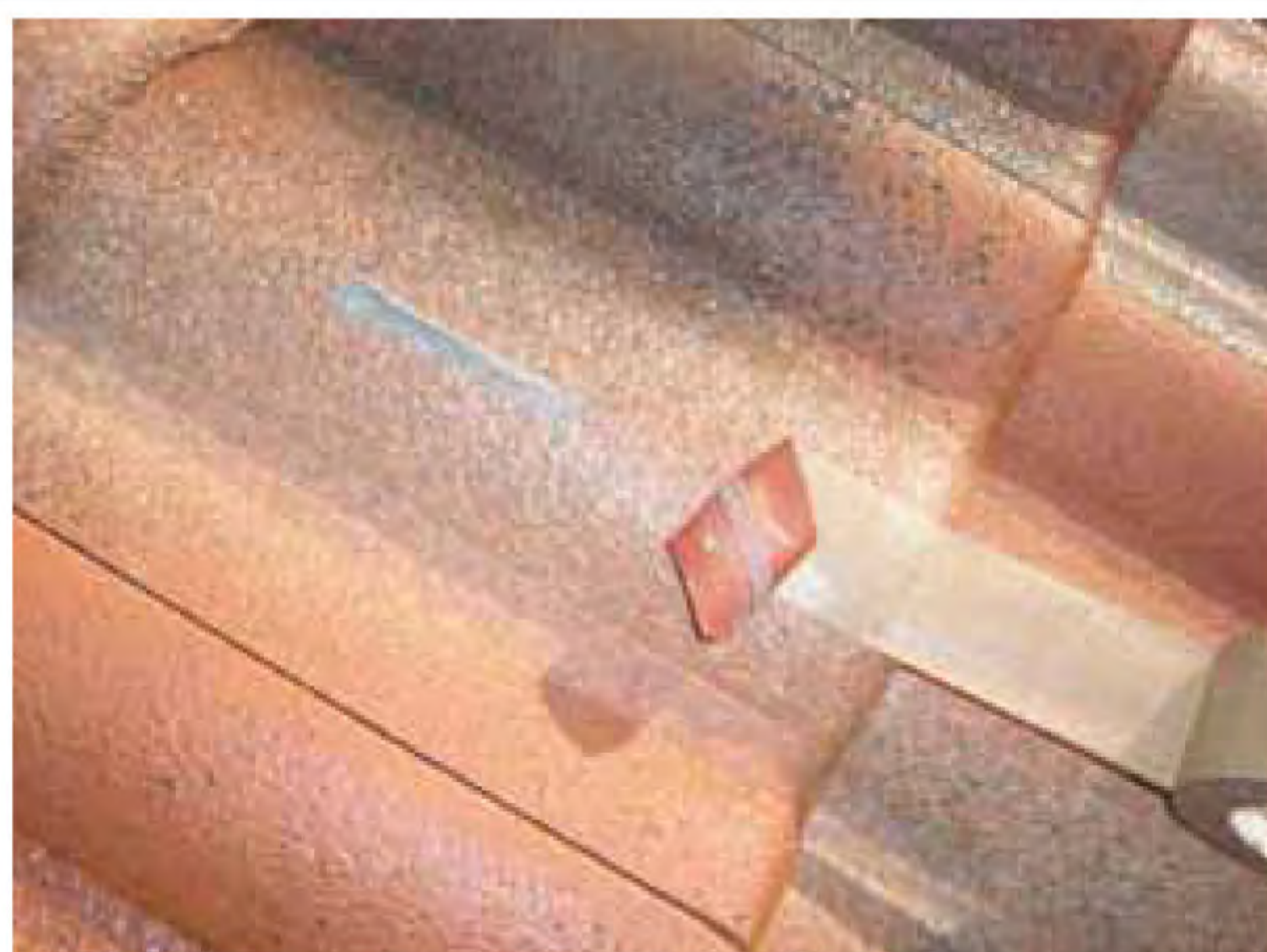
■万一、ブチルによって地瓦を汚損した場合は、布製ガムテープをブチルに貼り付けて引き剥がすと、除去できます。一度で取れない場合は、繰返し行ってください。
